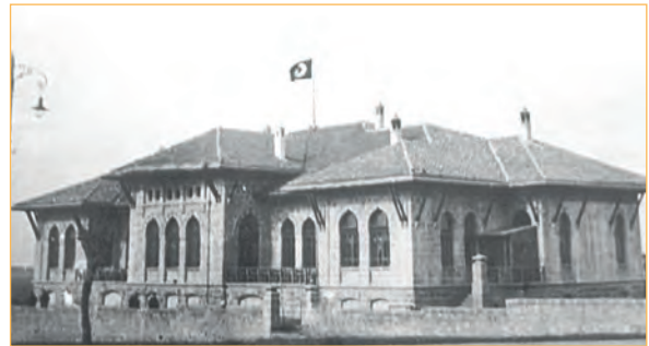
Görsel 4.1: I. TBMM binası (Kurtuluş Savaşı Müzesi)
