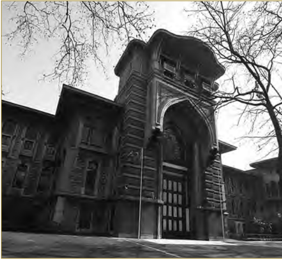
Görsel 5.7: Günümüzde İstanbul Erkek Lisesi olarak kullanılan Düyük-ı Umûmiye binasının girişi
