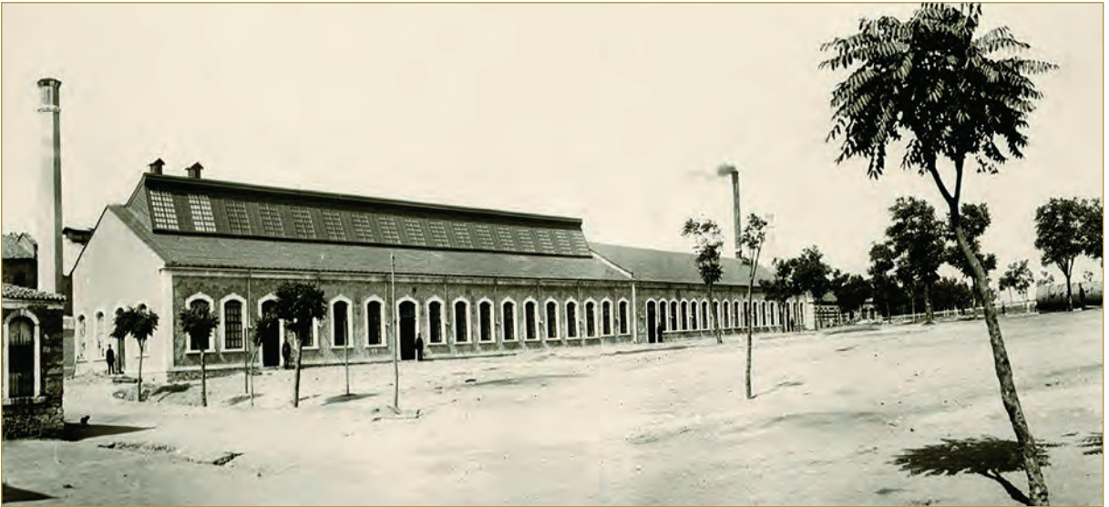
Görsel 5.1: Mavzer Fişek Fabrikası, İstanbul
