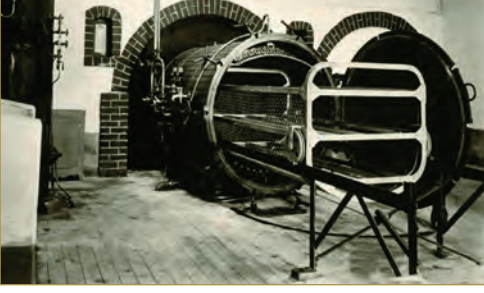
Görsel 5.24: Üsküdar Tebhirhanesinde basınçlı buharlı kazan, İstanbul
