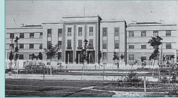
Görsel 1: 1926/27 yıllarına yapılan Sıhhiye Vekâleti (Sağlık Bakanlığı) Binası-Ankara
