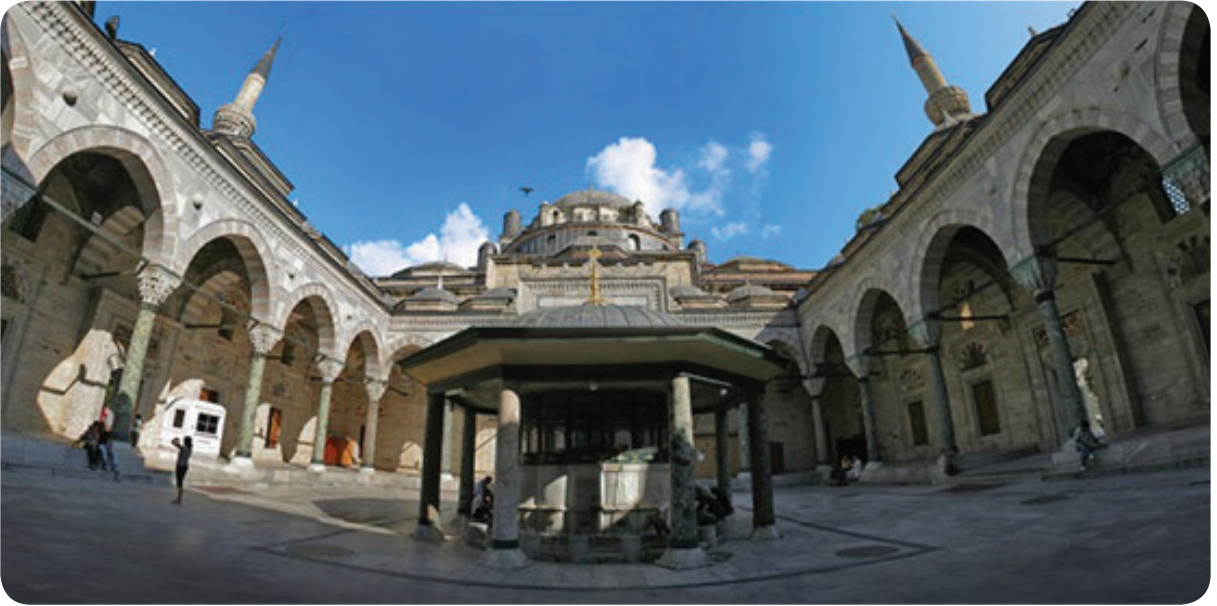
Küllîye, İslam dünyasında çok işlevli yapı kompleksi olarak ilim kurumları ekseninde ortaya çıkmış ve gelişmiştir. (Beyazid Cami ve Külliyesi)
