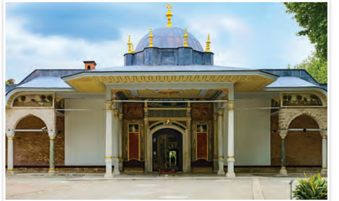
Görsel: 6.4: Topkapı Sarayı'ndaki Babüssaade'den bir görünüm
