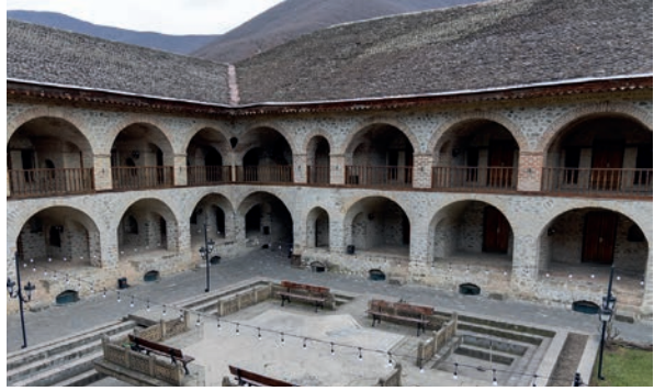
Şeki Kervansarayı'nın iç avlusundan bir görünüm, Şeki / Azerbaycan
